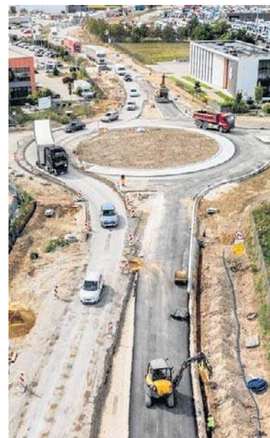
Budowa obwodnicy Niepołomic trwa od prawie trzech lat
