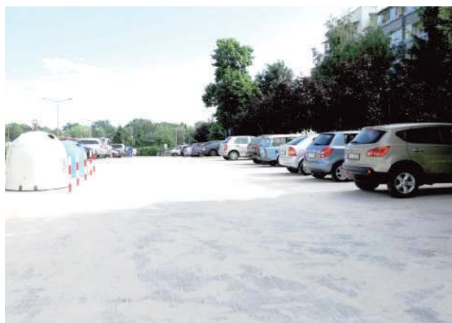
Gołym okiem widać, że parking jest świeżo po remoncie. Na kostce zalega jeszcze piach po układaniu nowej nawierzchni
