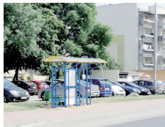
Teraz pasażerowie puławskiego MKZ na przystanku przy ul. Grota-Roweckiego nie zmkną. W ubiegły piątek rozpoczął się tu montaż wiaty przystankowej
