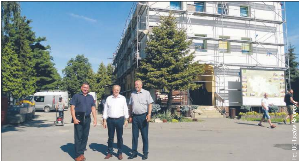
W budynku gminy zostanie także zamontowana winda.
