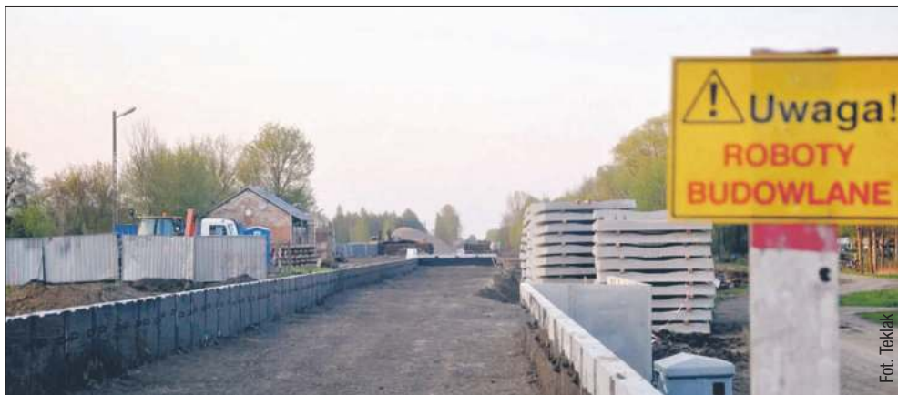
Trwa modernizacja linii kolejowej nr 25 na odcinku Padew - Mielec - Dębica.
