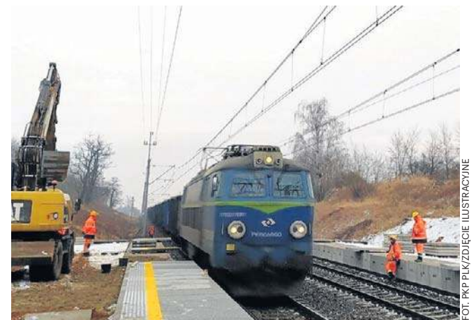
Na odbudowywane przez województwo tory linii Strzegom - Łagiewniki kiedyś mogą wjechać pociągi pasażerskie
