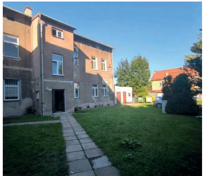
To budynek komunalny. Po prawej stronie są lokale wykupione przez prywatnych właścicieli.
