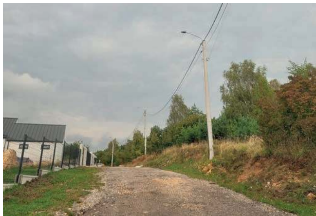
Końcowy odcinek ul. Na Wzgórze w Trzebinii
