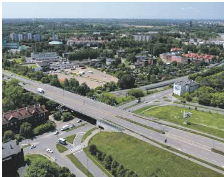
Całkowity koszt remontu wiaduktu to 33 mln zł
