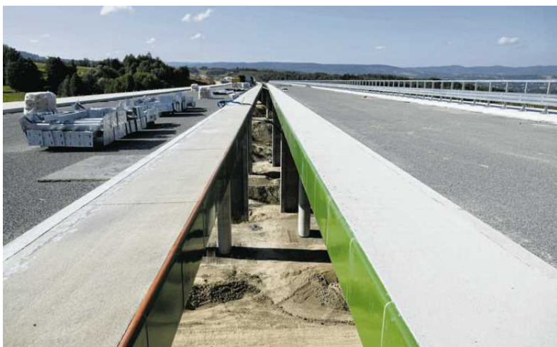
• Budowa drogi ekspresowej S19 na odcinku Babica – Jawornik FOT. PATRYK OGÓRZAŁEK / AGENCJA WYBORCZA.PL
