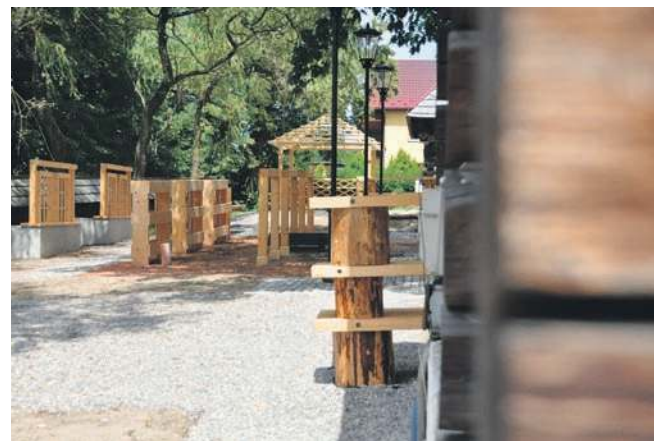
Na tzw. rynku małomiasteczkowym trwają roboty
