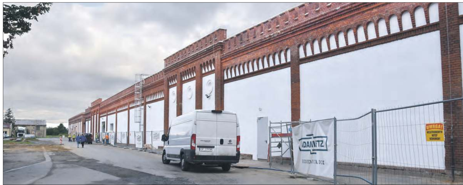
Zmodernizowana część hal ma już odnowioną elewację
