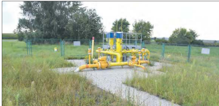
Rozbudowa gazu przy ul. Przemysłowej w Prudniku
