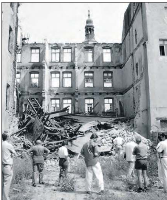
Pamiętna katastrofa budowlana kamienicy przy ul. Armii Krajowej. Na szczęście budynek był już niezamieszkały. Co ważne udało się uratować zabytkową elewację, za którą stoi dziś zupełnie nowy budynek.
