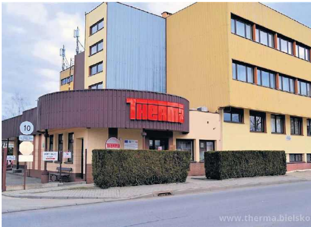
Therma ma ponad 185 km sieci ciepłowniczej i zajmuje się zakupem, przesyłem oraz dystrybucją ciepła w Bielsku-Białej
