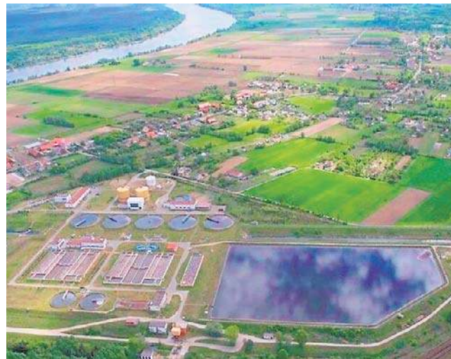
Bydgoska oczyszczalnia Kapuściska
