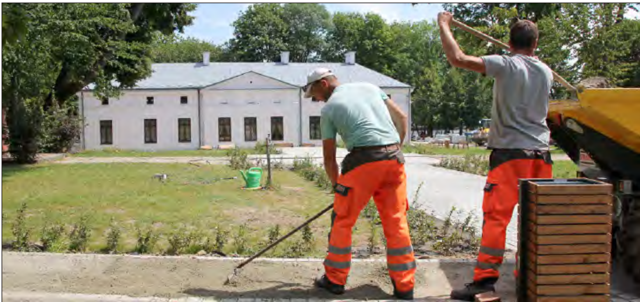
5 lat temu rewitalizację przeszło otoczenie „pałacyku”. Teraz przyszedł czas na sam budynek, którego kilkanaście lat temu elewacja i dach zostały również odnowione. Teraz prace skupią się na wnętrzu zabytkowego dworku (fot. archiwum TG)
