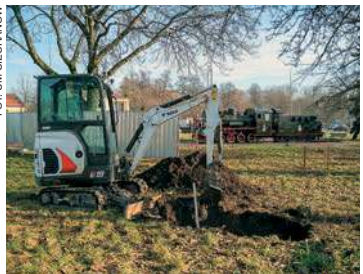
Rekonstrukcja budynku Kolei Nadwiślańskiej
