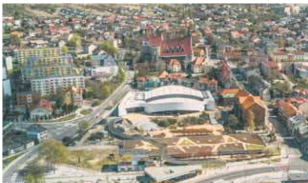
Prace remontowe mają zakończyć się w czerwcu
