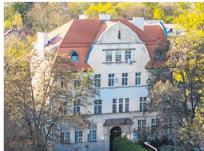
Drugie życie dostanie budynek przy ul. Eluarda 2
