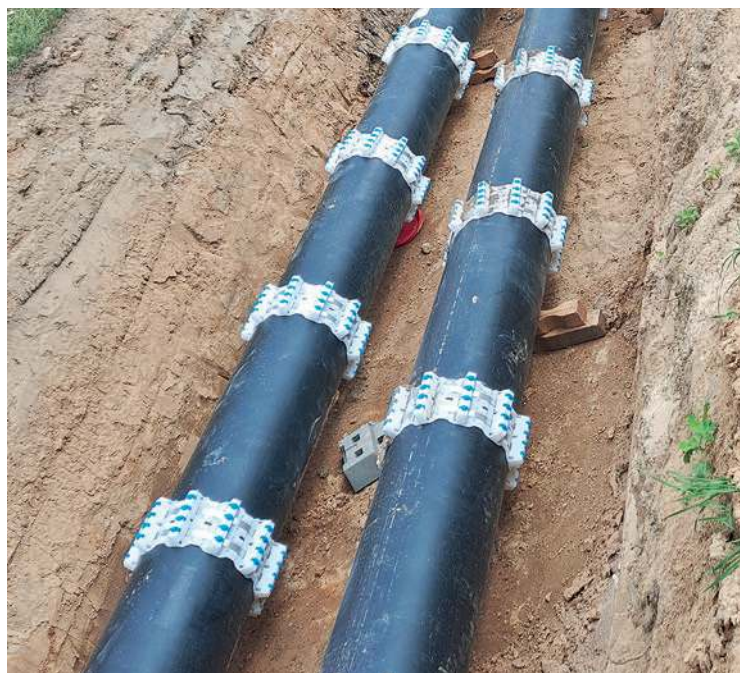
Sieć ciepłownicza preizolowana DN350 w ul. Sikorskiego
