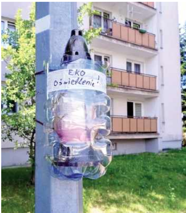
Według opisu przedstawionego przez wóldarza miasta mieszkaniec był odsyłany pomiędzy Urzędem Miasta a Radzyńską Spółdzielnią Mieszkaniową, ponieważ latarnia formalnie nie należy do miejskiej infrastruktury. Przez ten czas problem pozostawał nierozwiązany
