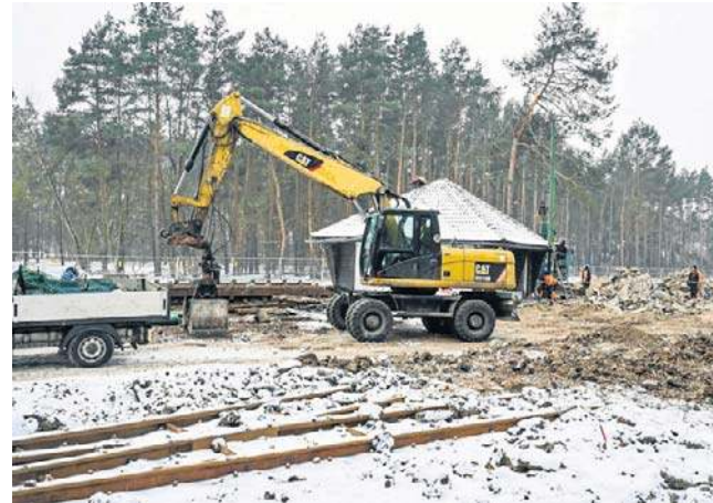
Prace budowlane na pętli ruszyły na początku 2026 roku
