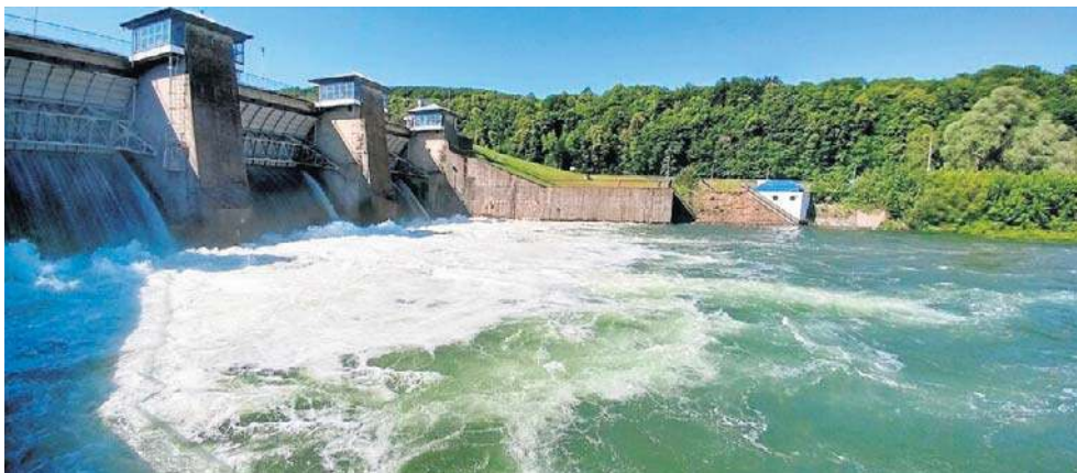
Prace na odcinku od zapory myczkowieckiej do elektrowni mają trwać 4 lata i podyktowane są ochroną przeciwpowodziową
