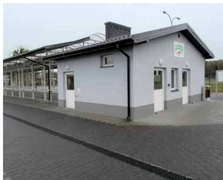
Gmina Ojrzeń - Wsparcie lokalnego rozwoju Gminy Ojrzeń poprzez rozbudowę dróg: Kraszewo - Skarżyniek - Łębki Wielkie; w miejscowości Bronisławie i przebudowę ul. Przedszkolnej w miejscowości Ojrzeń
