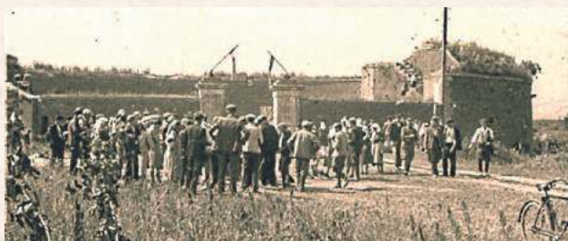
Zamojska Rotunda. Zdjęcie wykonano w 1944 r. Fot. ze zbiorów APZ
