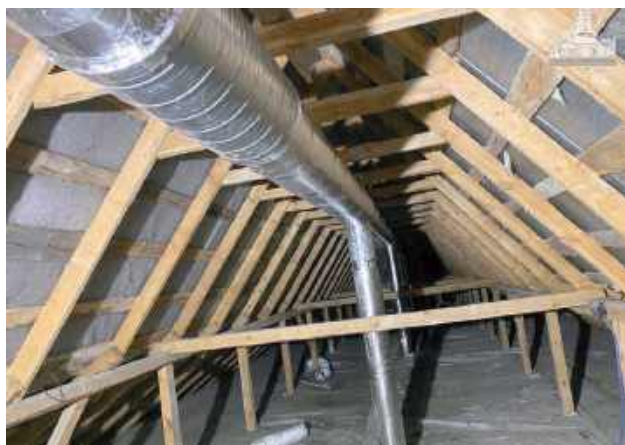
Prace rozpoczęte latem zostały zakończone. Urządzenia wentylacyjne zainstalował Paweł Tchorek (Parafia Świętego Izydora Oracza w Marianowie)
