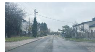
Ulica Mościckiego od dawna wołała o remont
