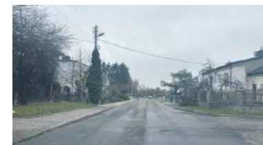
Ulica Mościckiego od dawna wołała o remont
