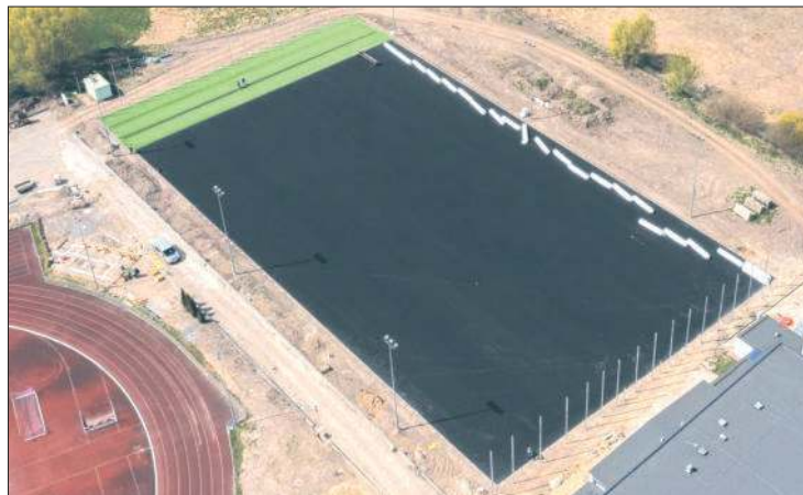
Teren HOSiR przechodzi gruntowną przebudowę.
