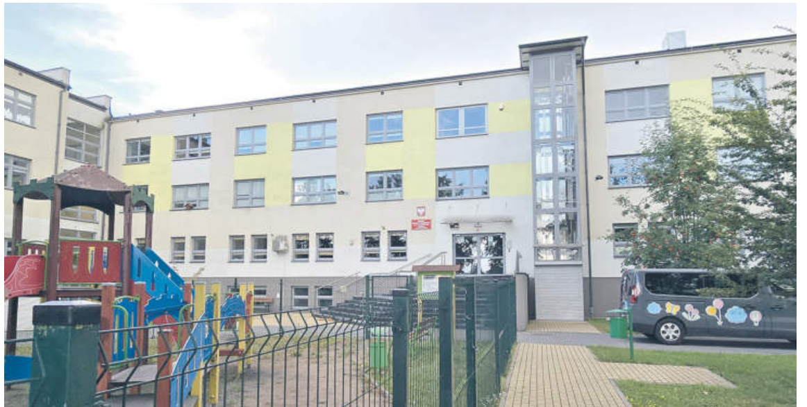
Budynek Specjalnego Ośrodka Szkolno-Wychowawczego im. M. Grzegorzewskiej w Siedlcach przy ul. Kazimierzowskiej.
