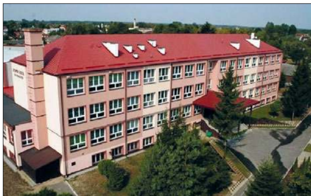
Budynek ZPO w Łomazach przejdzie gruntowną modernizację
