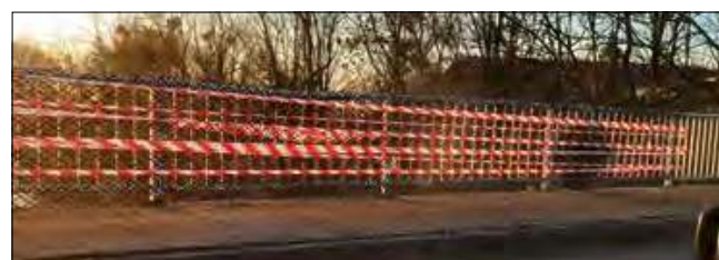
Barierka na moście została zabezpieczona.
