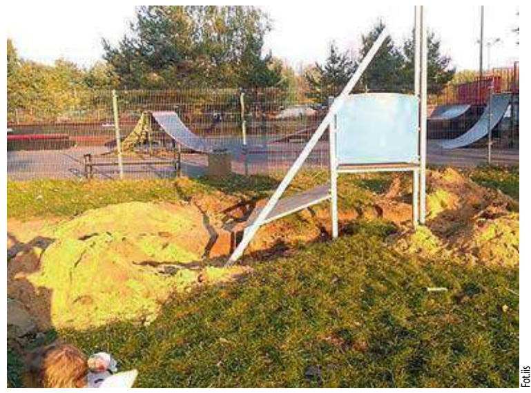
Park na osiedlu Fabrycznym - rozkopy przy skateparku
