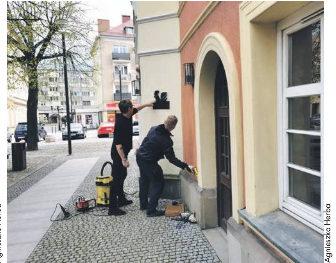
Koguta zamontowano w rynku od strony szklanych pawilonów
