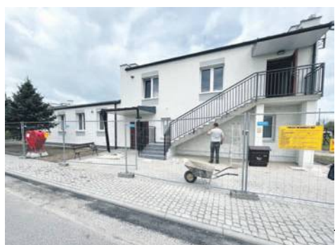
Trwa przebudowa wraz z termomodernizacją budynku świetlicy w Stanowicach.
