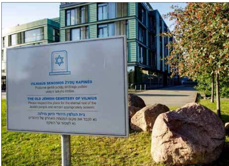
Gmach znajduje się na terenie dawnego cmentarza żydowskiego, istniejącego od XVI w. Miejsce pochówków wciąż nie zostało odpowiednio uporządkowane
