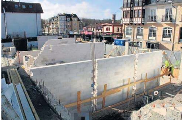
Prace budowlane przy deptaku w Mielnie są już mocno zaawansowane
