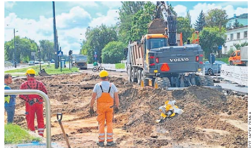
Remont ulicy Wróblewskiego już się rozpoczął
