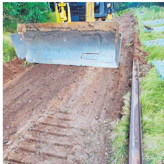
Prowadzone są kolejne etapy remontu torowiska
