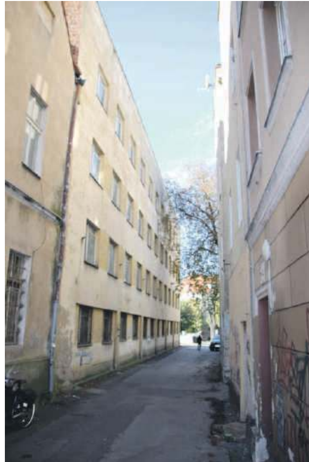
Zdjęcie zrobione w 2022 r na ul. Karola Miarki - po lewej budynek wybudowany na początku lat 70. przez Spółdzielnię Inwalidów
