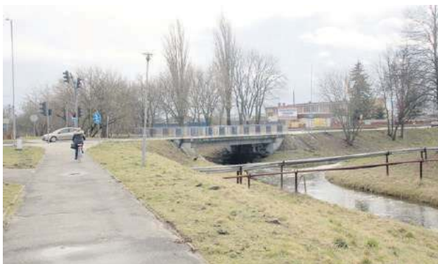
Most na rzece Łabuńce przy ul. Lipskiej
