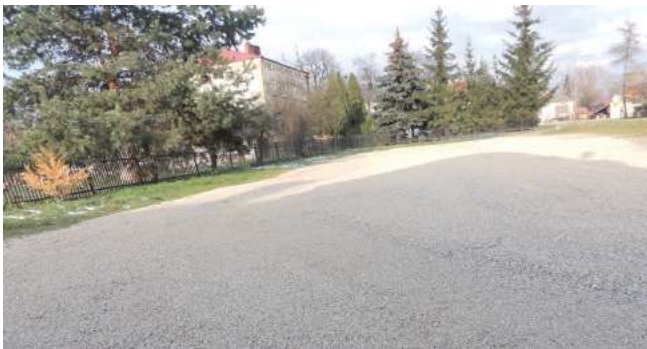
Według szacunków przewodniczącego Rady Powiatu w Opolu Lubelskim w listopadzie ub.r. na kościelny parking trafiło około 15 ton materiału kamiennego należącego do Zarządu Dróg Powiatowych
