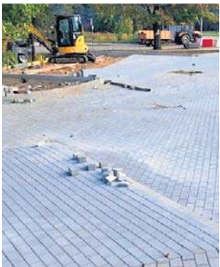
Trwa budowa parkingu przy stacji PKP w Bielsku Podlaskim
