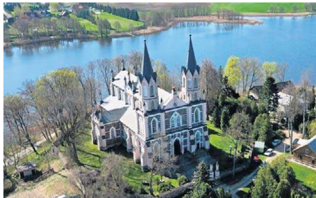
Kornik niszczy zabytkowe elementy kościoła w Puńsku. Naprawy potrzebują już organy i fragmenty ołtarza
