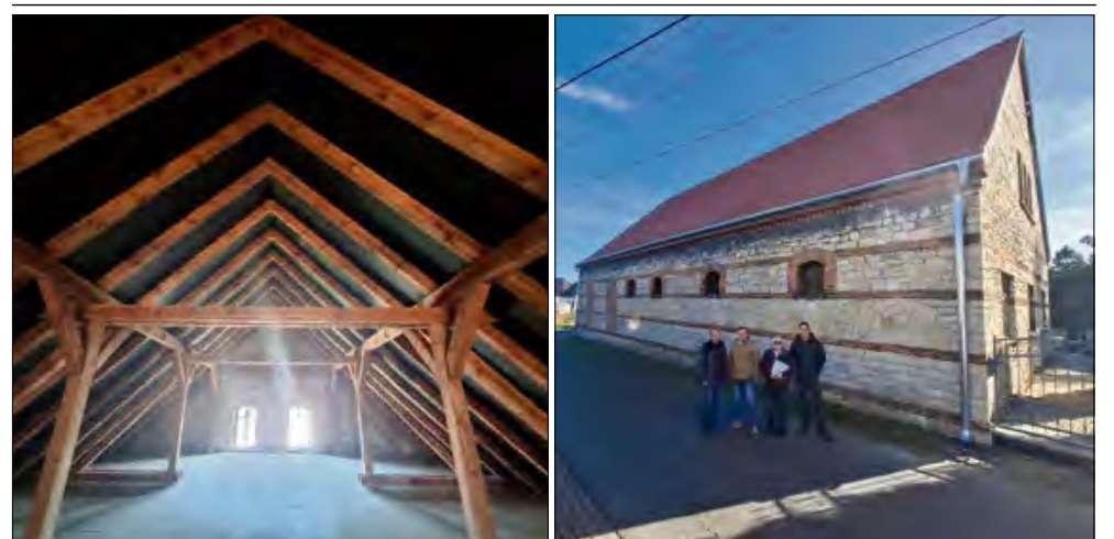
Roboty wykonała firma Budopap z Krapkowic.
