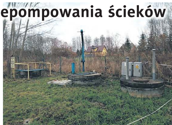
Obecna przepompownia ścieków w Drożdzienicy zostanie zlikwidowana.
