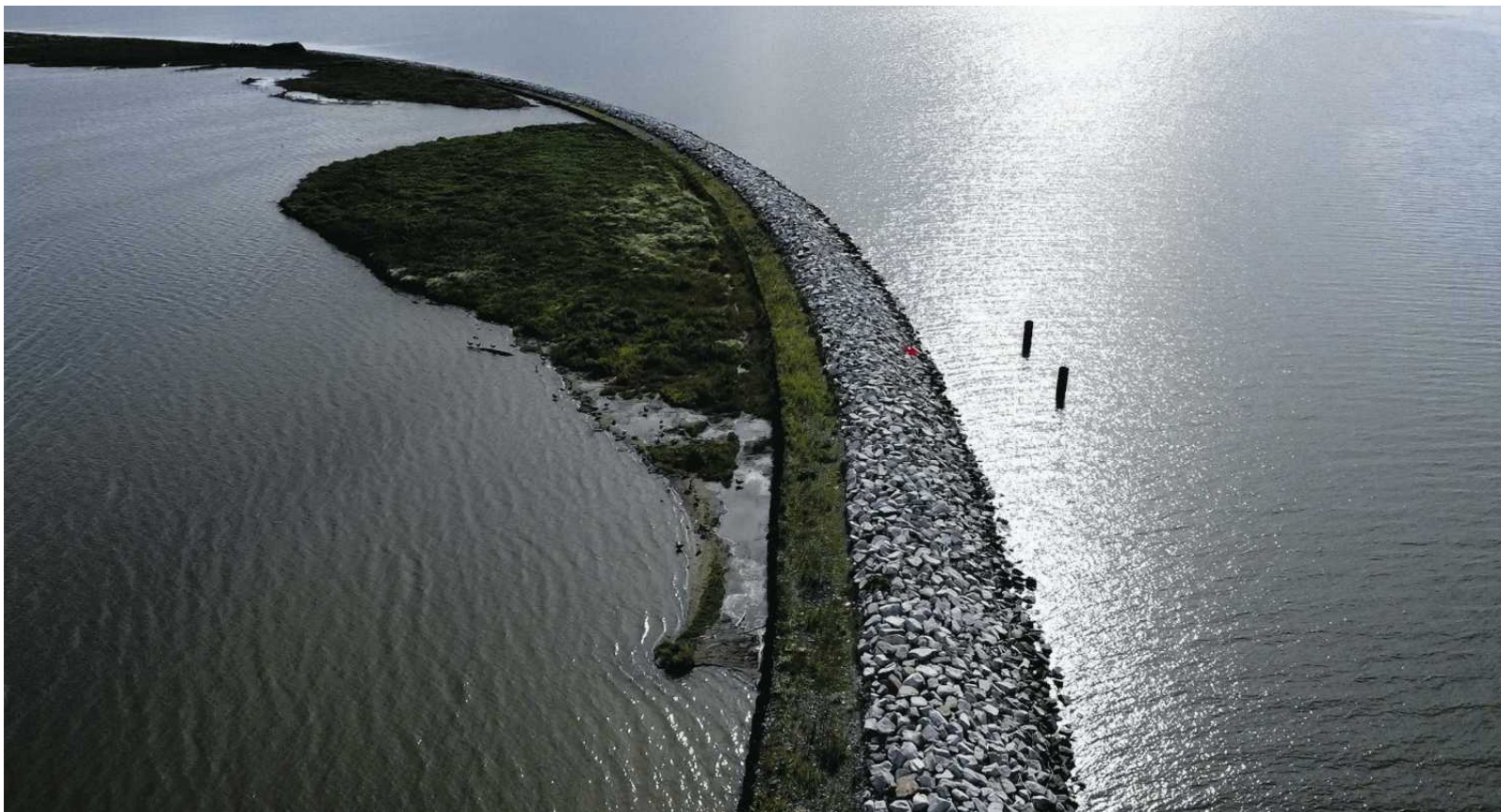
• Wyspa Estyjska FOT. URZĄD MORSKI W GDYNI
