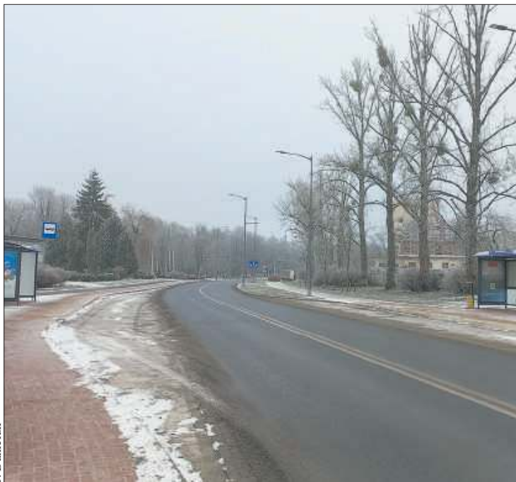
Przebudowany fragment ul. Łukasiewicza pomiędzy ul. Nowowiejskiego i Al. Kobylińskiego
