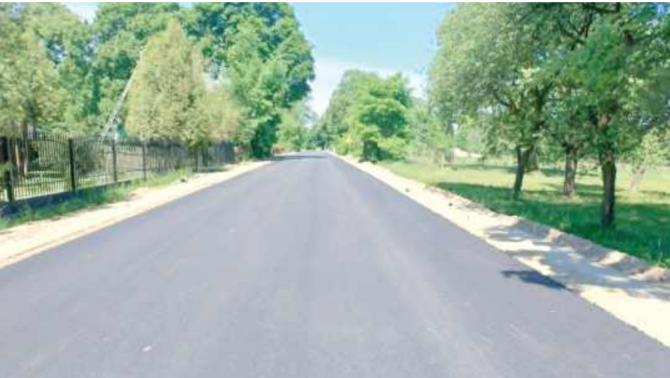
Ułożony został już nowy asfalt
