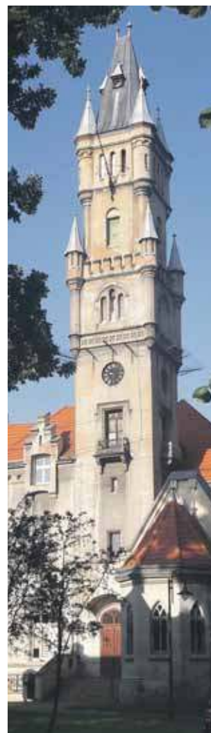
Nie tylko wieża wymaga remontu
