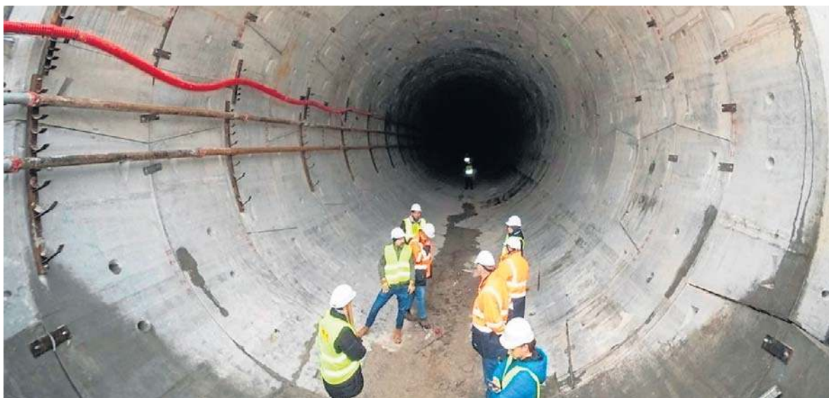
Budowa tunelu stała niemal dokładnie rok temu. I nic w tej sprawie się nie zmienia
