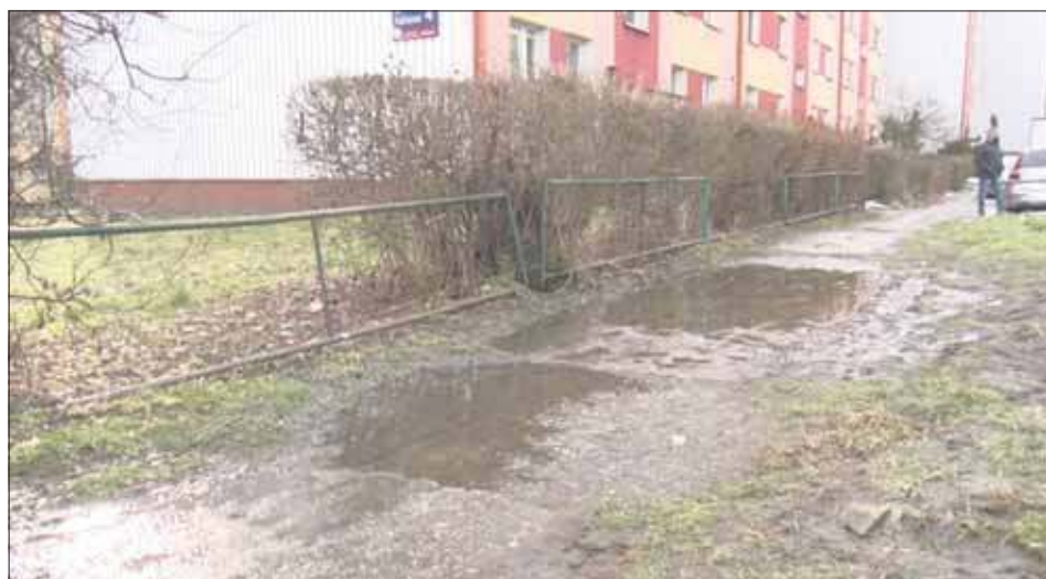
Kłopotliwa dziura w chodniku na Kalinowej
