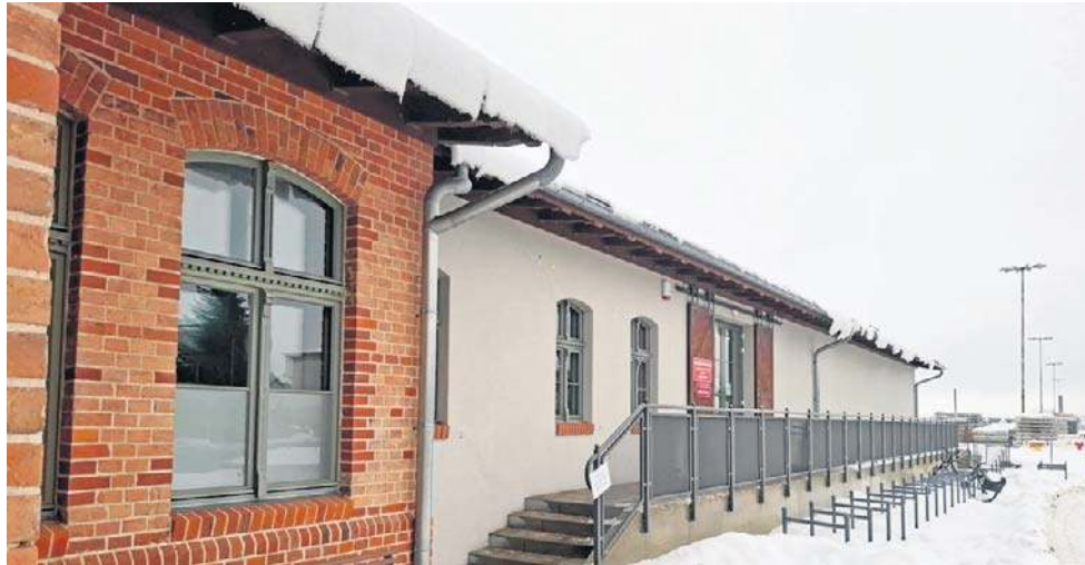
W budynku po byłym magazynie działa filia Pomorskiej Biblioteki Pedagogicznej
