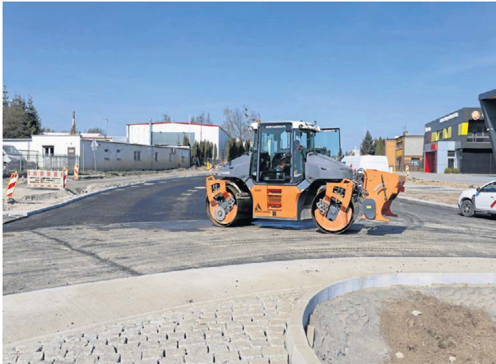
Asfaltowanie fragmentu ringu na ul. Słonecznej
