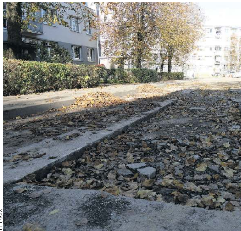
Budowa odwodnienia przy ulicy Westerplatte
