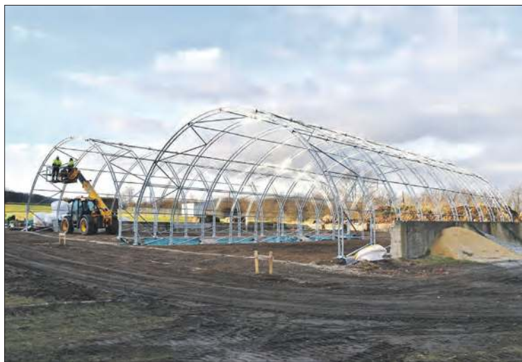
Budowa hal łukowych na siano
