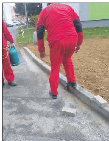
Prace przy budowie krawężników
